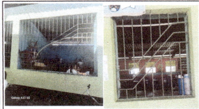
Foto 3: VENTANAS: mantenimiento de balcon de metal. 40M2
