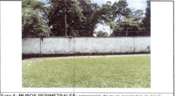
Foto 6: MUROS PERIMETRALES: reparación de muro perimetral de block 43M2.
