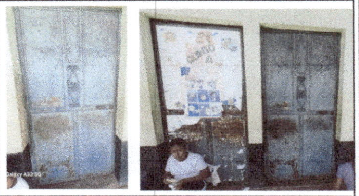
Foto 2: PUERTAS DE METAL: mantenimiento a estructura (lijado, cambio de tubo, cepillado, sujeciones) y sustitución de chapa, 13 puertas
