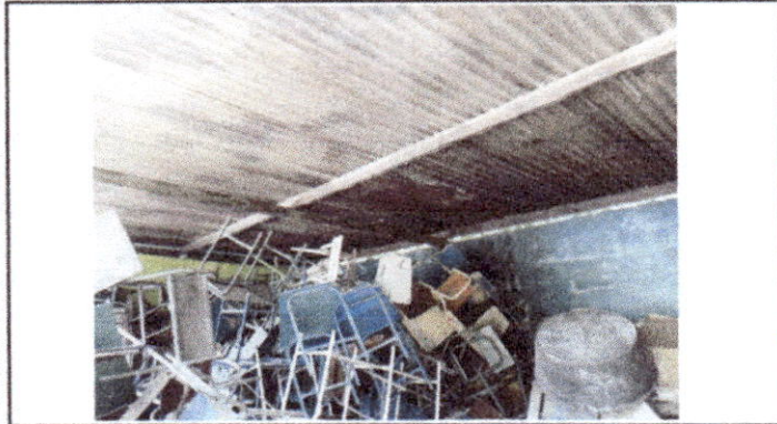
Foto1: Sustitución de lámina, Estructura de metal.
