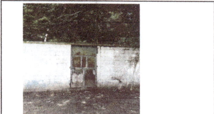
Foto 10: Fabricación e instalación de puertas
