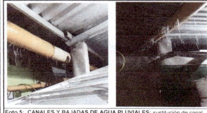
Foto 5: CANALES Y BAJADAS DE AGUA PLUVIALES: sustitución de canal de PVC 18ML
